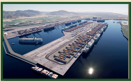
ETAPA 2 Preparación del terreno a cargo de ASIPONA / Construcción de terminales a cargo de privados
