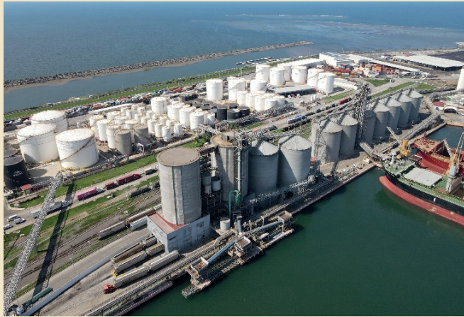
TERMINAL MARÍTIMA DE VERACRUZ (TMV): CONSTRUCCIÓN DE DOS SILOS
